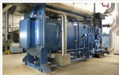
Absorptionswärmepumpe zur Nutzung industrieller Abwärme (Foto: Wikipedia/Reinraum)
